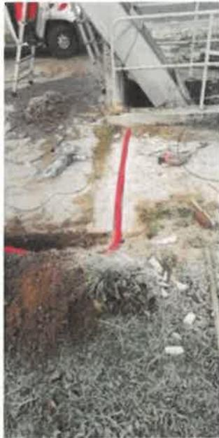
**Renouvellement du câble électrique du dégrilleur de la station d'épuration des Grivelles**
