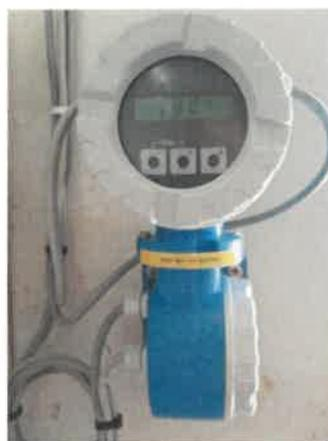
**Mise en place d'un débitmètre pour comptabiliser l'arrivée des effluents à la station d'épuration des Grivelles**
