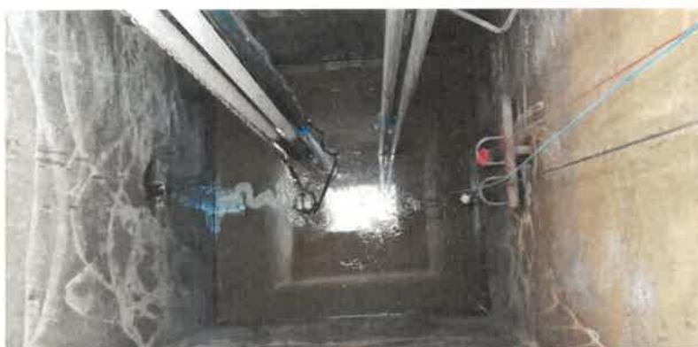
**Mise en place d'une deuxième pompe dans le poste de relèvement de la station d'épuration des Grivelles**
