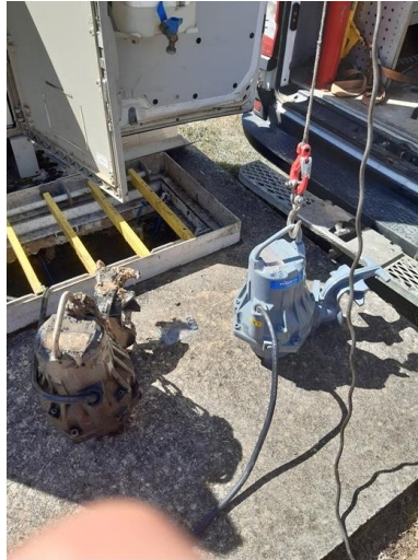
Renouvellement d'une pompe au poste de relèvement rue du Collège
